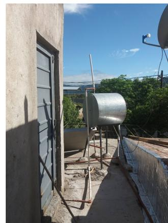
**Figura 2.18:** Soluciones constructivas para reducir el consumo de energía: construcción de pérgola en fachada norte (izquierda) e instalación de calentador solar (derecha) [Fotos Lucio A. Molas].
