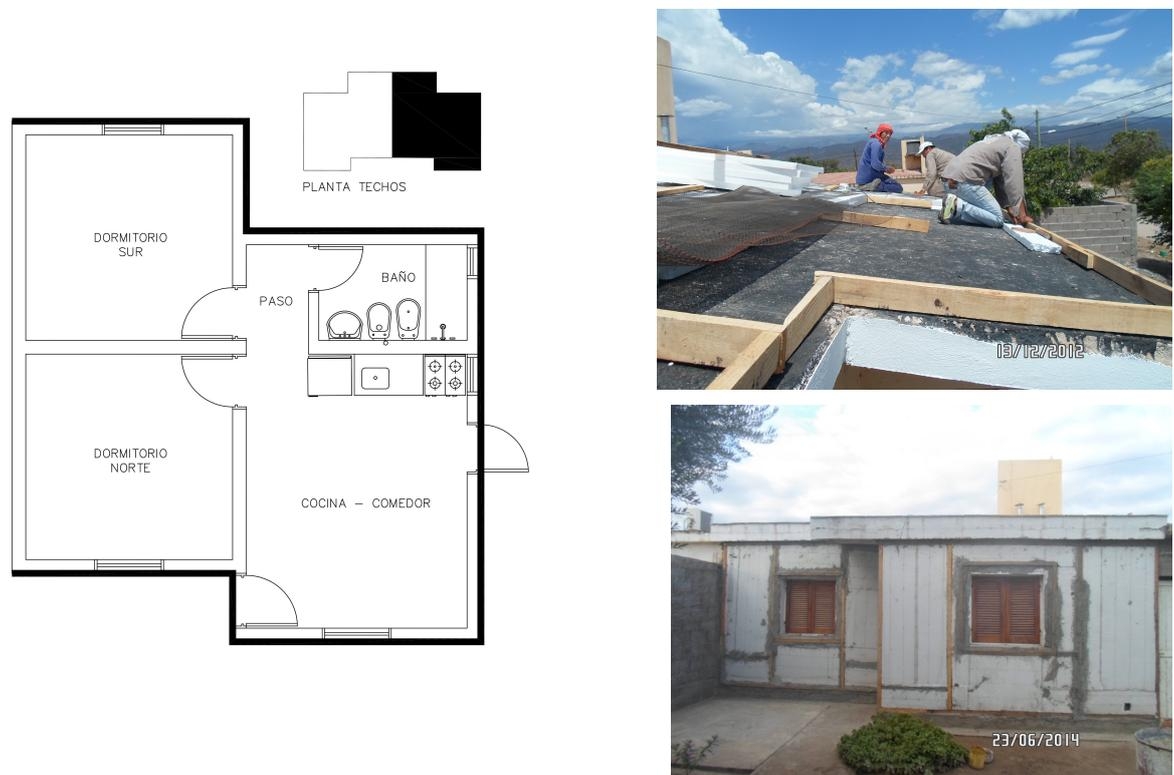
**Figura 6.1:** M1: aislamiento térmico. Ubicación en planta de las envolventes verticales y horizontal (izquierda) [Elaboración propia] y la construcción (derecha) [Fotos Lucio A. Molas].
