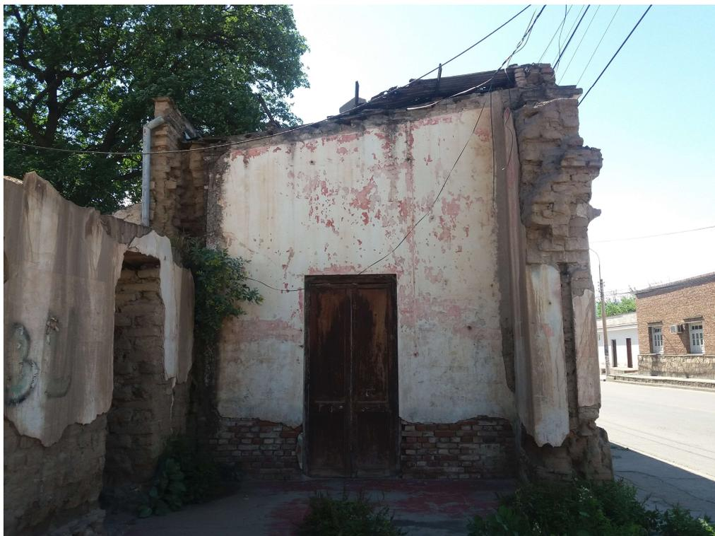
**Figura B.5:** Imagen de una vivienda vernácula italianizante, parcialmente demolida, donde se observan los tres sistemas constructivos [Elaboración propia].
