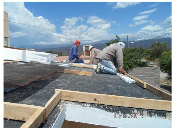
**Figura 2.16:** Ejecución de las mejoras tecnológicas en el techo. Izquierda: remoción de las bovedillas. Derecha: colocación de la aislación térmica [Fotos Lucio A. Molas].
