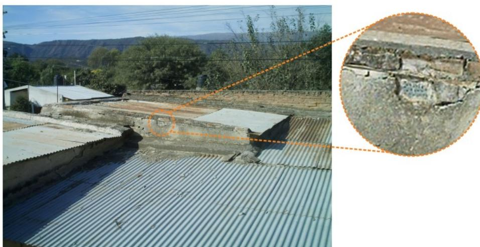
**Figura B.6:** Blindaje y rejilla de ventilación del sistema constructivo de doble cubierta ventilada [Elaboración propia].
