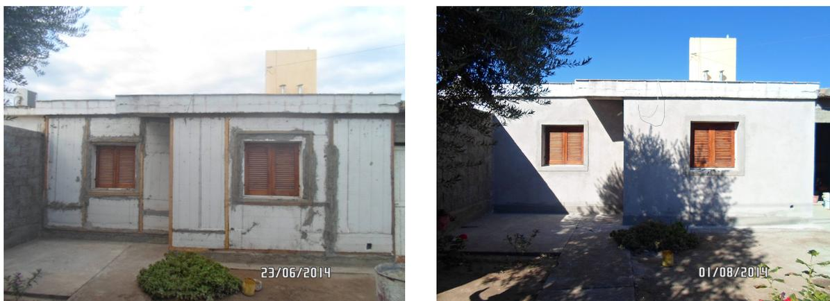
**Figura 2.17:** Ejecución de las mejoras tecnológicas en la mampostería. Izquierda: colocación de la aislación térmica. Derecha: terminación con revoque fino [Fotos Lucio A. Molas].
