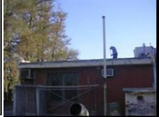
Figura N° 3- Construcción techo con aislación
