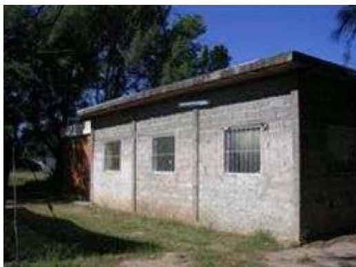
Figura N° 4- Ventanas fachada Norte
