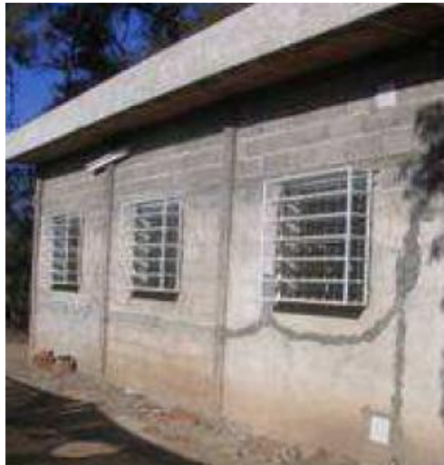
Fig. 7. Ubicación de estantes en la ventanas fachada norte
