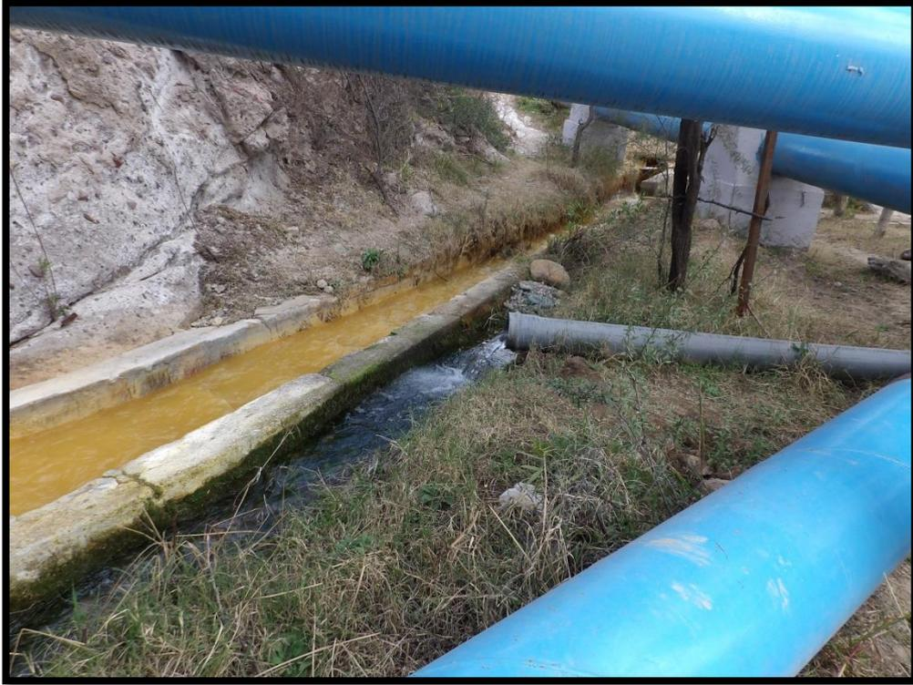
**Figura 2.4 Santa Florentina, a 20 metros del Azud del Distrito. Cañerías de conducción de acceso a planta de Agua Potable. Al centro, conducción Canal Matriz para Riego**
