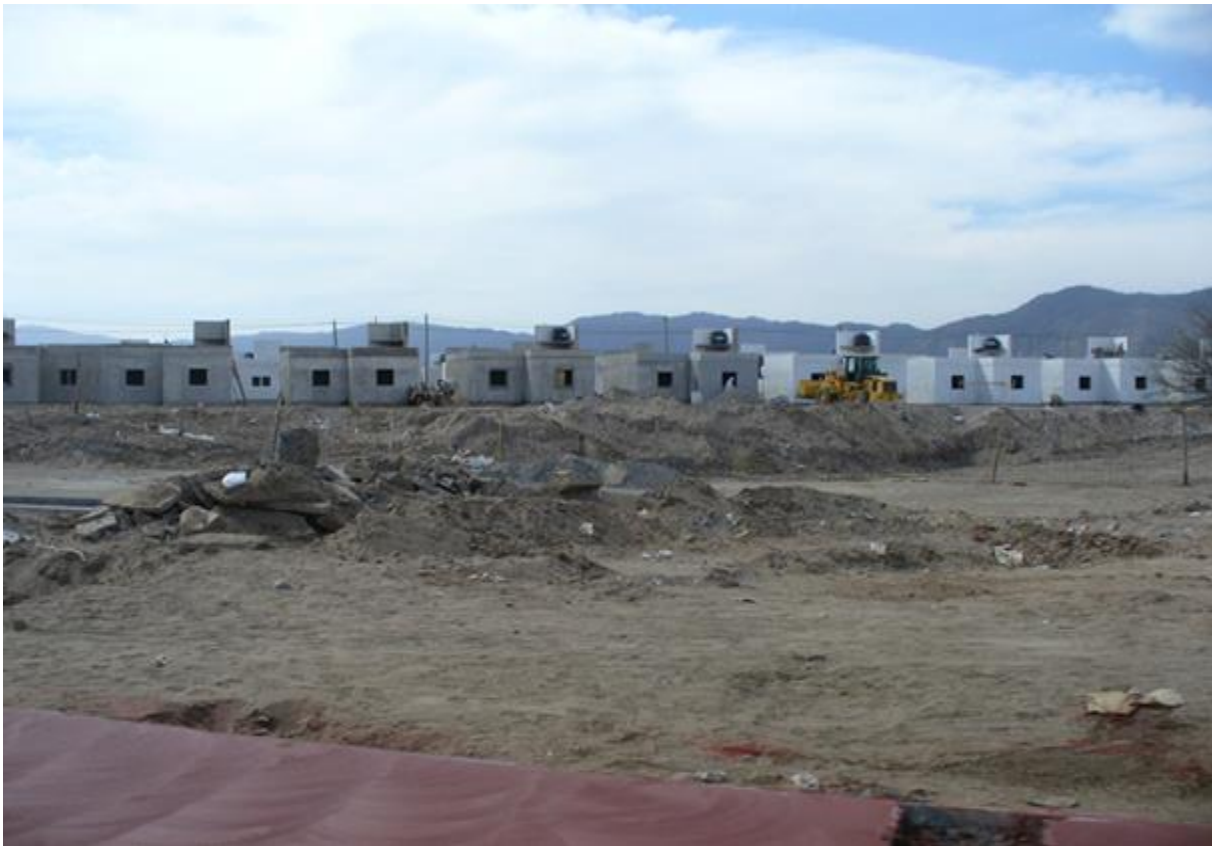
Foto N° 1: Barrio en construcción sobre suelos previamente deforestadas en su totalidad.
