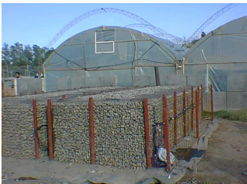
Figura 8. Vista de los dos módulos del lecho de piedra en su etapa de construcción.
