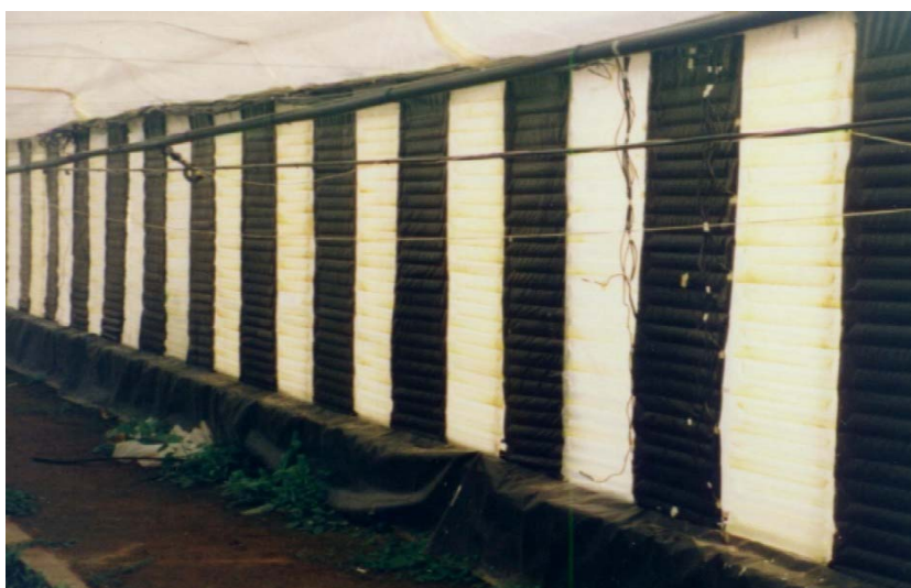
Figura 5. Vista interior de la pared Norte del invernadero. Bolsas colectores solares transparentes y negras.
