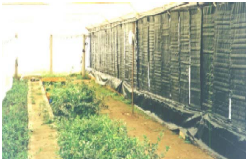
Figura 6. Vista interior de la pared Sur del invernadero. Bolsas colectores solares negras.
