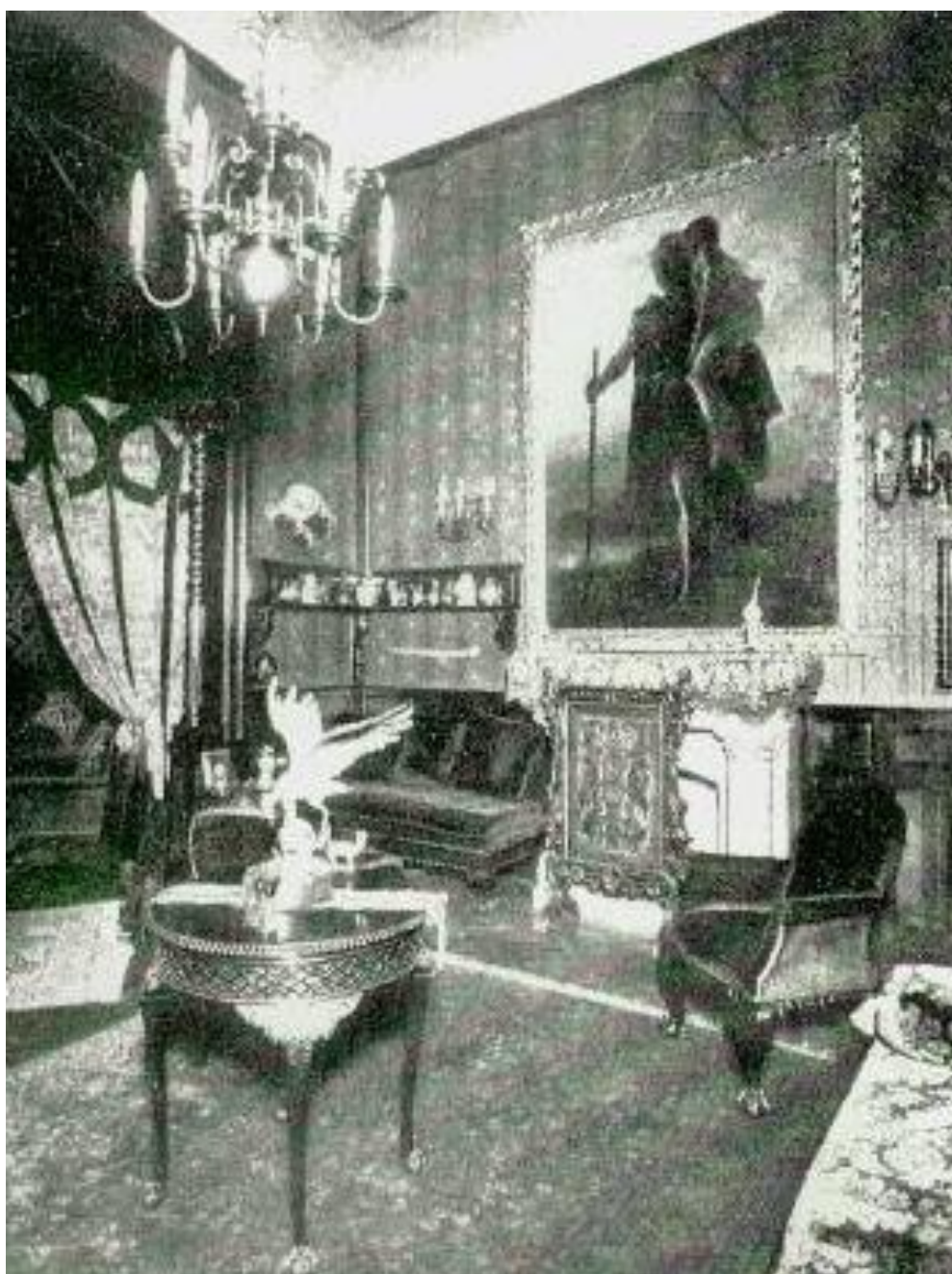
Vista del fumoir de la casa de los Estevez.
